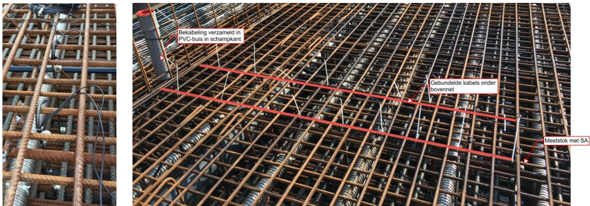
Figuur 3.11 Impressie montage meetstokken. L: Meetstok in wapeningsnet. R: Bekabeling naar toekomstige trekput in schampkant
